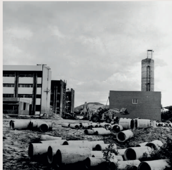
Figura 04: registro do canteiro de obra em 1976 Fonte: São Thiago, 1983
