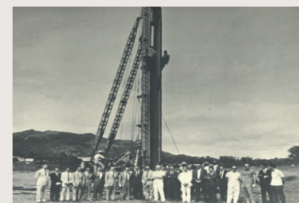
Figura 02: registro do início do estaqueamento - nov/1965 Fonte: São Thiago, 1983
