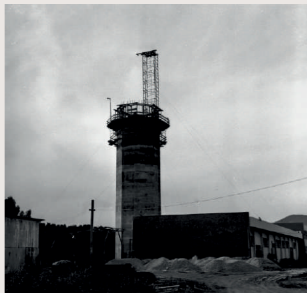
Figura 03: registro do canteiro de obra em 1976 Fonte: São Thiago, 1983
