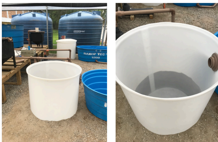
Figura 32. Nivelamento filtro biológico
