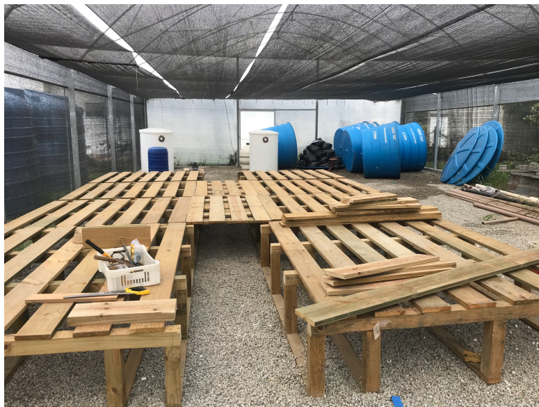
Figura 28. Montagem das plataformas de manejo
