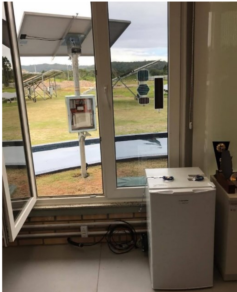
Figura 17 - Visão geral do experimento. Ao fundo (área externa), o módulo solar fotovoltaico e a caixa fixada ao poste, onde se encontram o controlador de carga, as baterias, o BMS e o conversor elevador de tensão CC-CC. Na frente (área interna), o refrigerador de 100 L.
