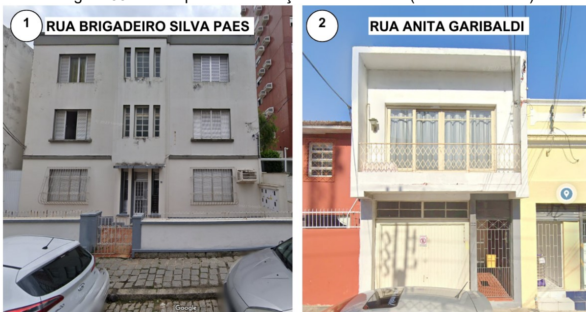
Figura 55 – Exemplos de edificações residenciais (baixa densidade)
