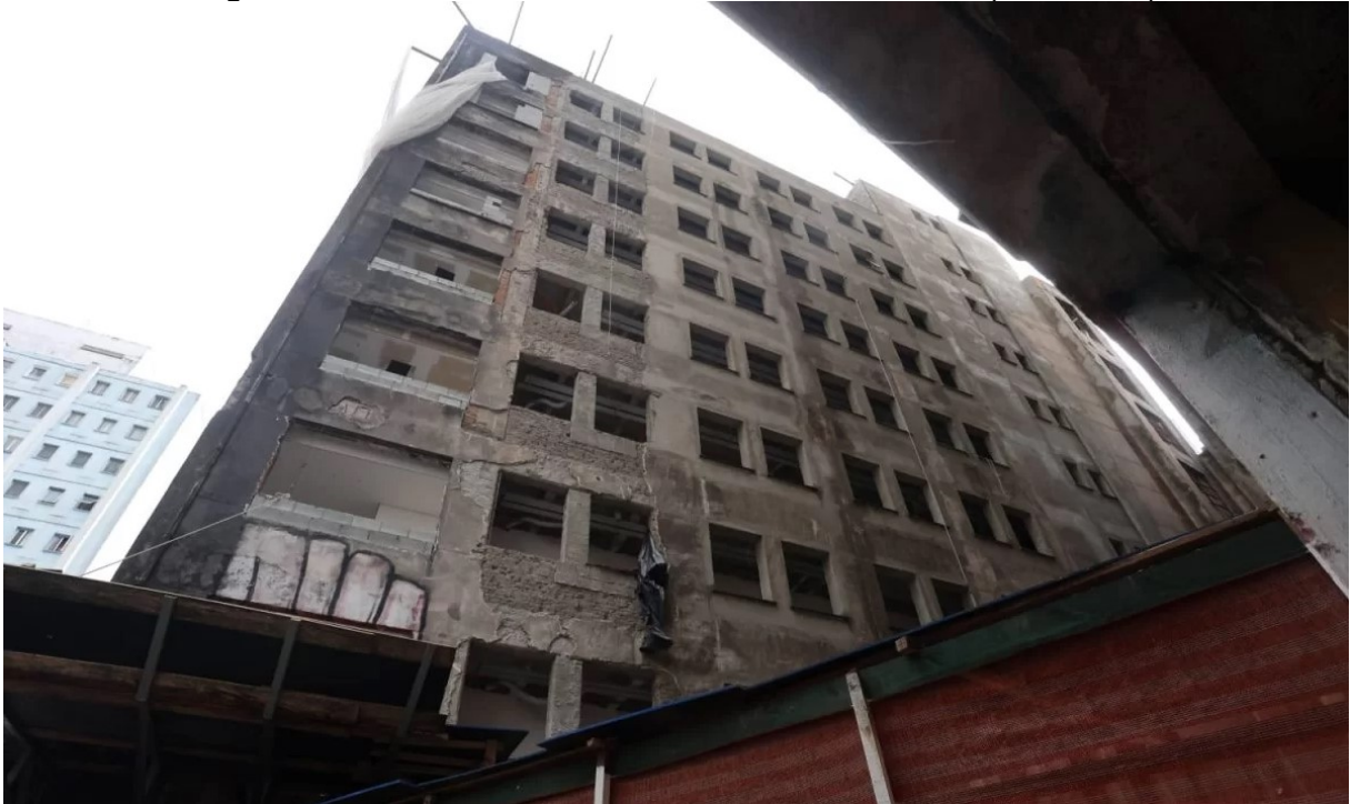
Figura 11 – Estado atual do Edifício Prestes Maia (em obras)
