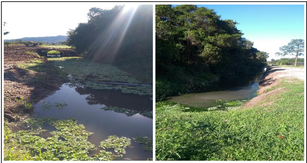
Figura 37 - Canal de drenagem
