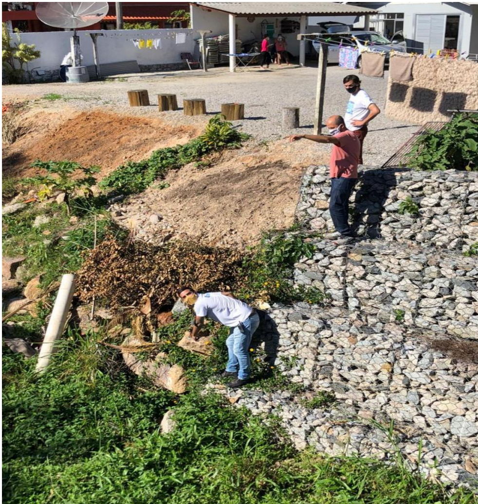
Figura 2 - Força-tarefa avalia situação de córrego d'água, em Ratonés, que recebe grande fluxo de esgoto irregular.
