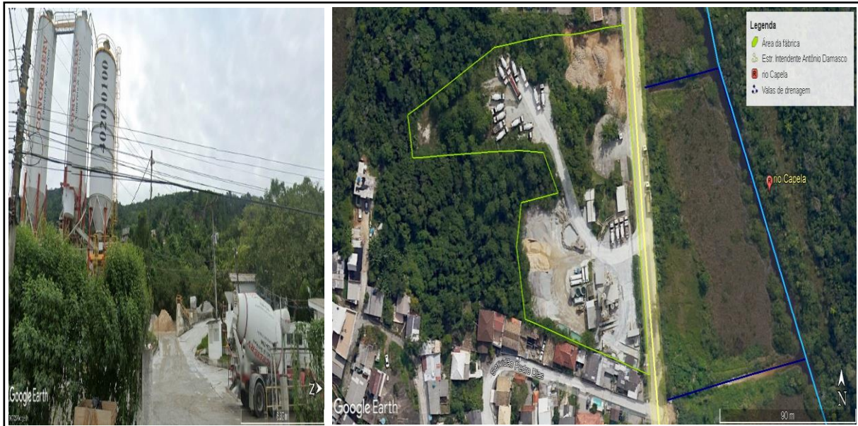
Figura 9 - Fábrica de concreto usinado
