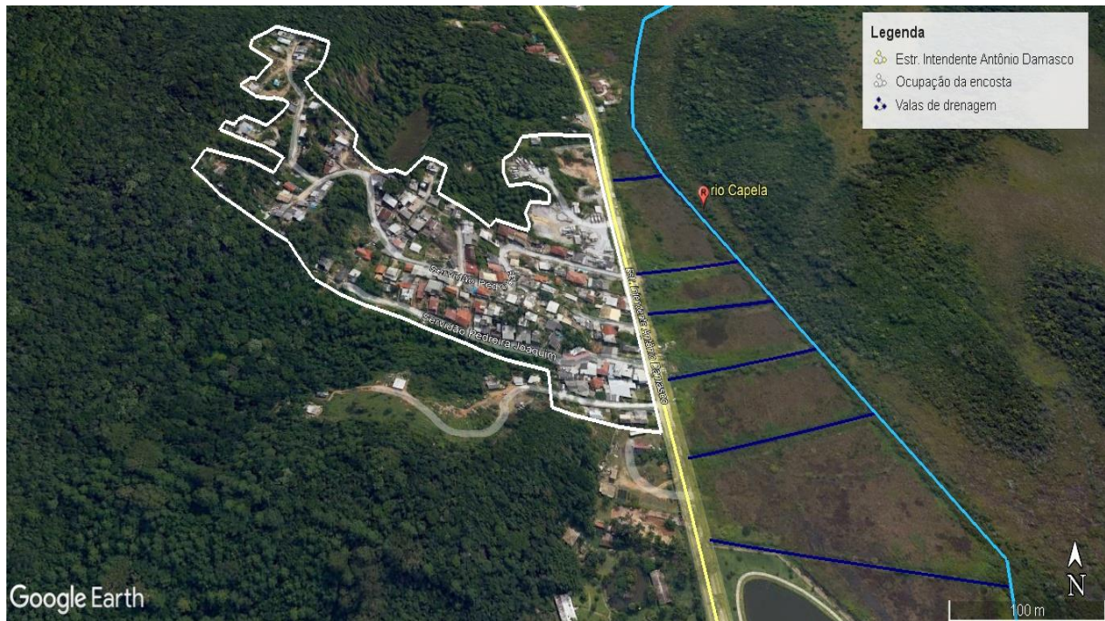
Figura 4 - Ocupação da encosta
