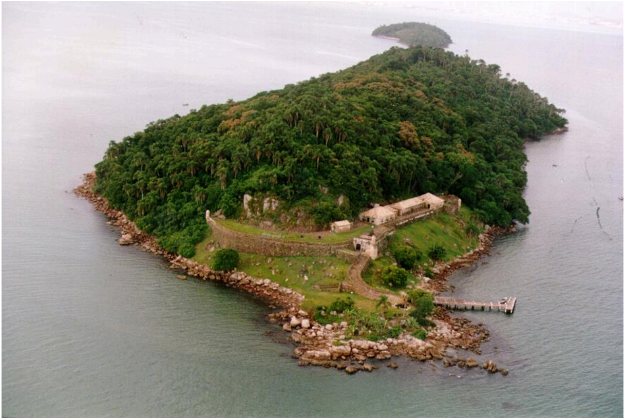
Figura 12 - Vista geral da Fortaleza de Santo Antônio de Ratonos
