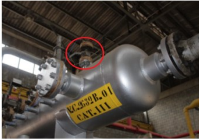
Figura 48 - Caso de estudo: Vent da linha de sucção do primeiro estágio.
