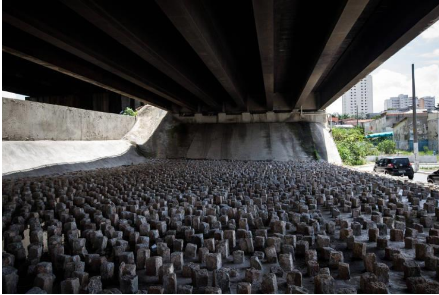
Figura 17 - Pedras instaladas sob viaduto Dom Luciano Mendes, na zona leste da capital.
