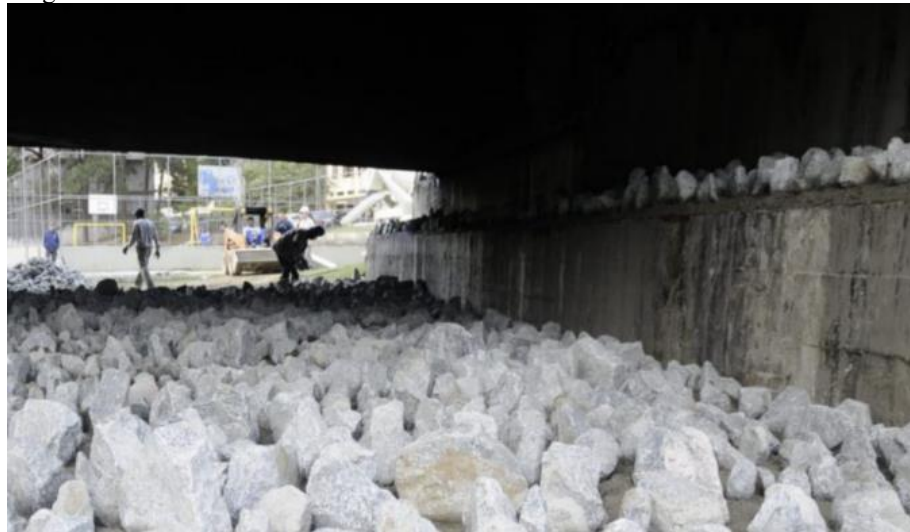
Figura 18 - Pedras instaladas sob o Viaduto Antônio de Paiva Monteiro.
