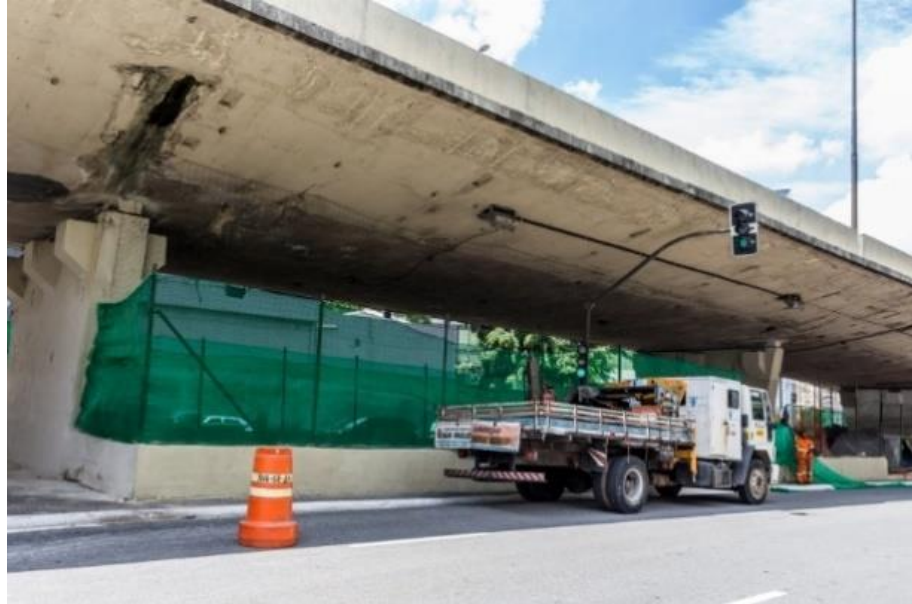
Figura 15 - Vista externa de viaduto envelopado.
