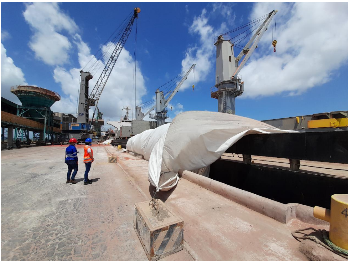
Figura 9: Lona de costado colocada entre o navio e o cais
