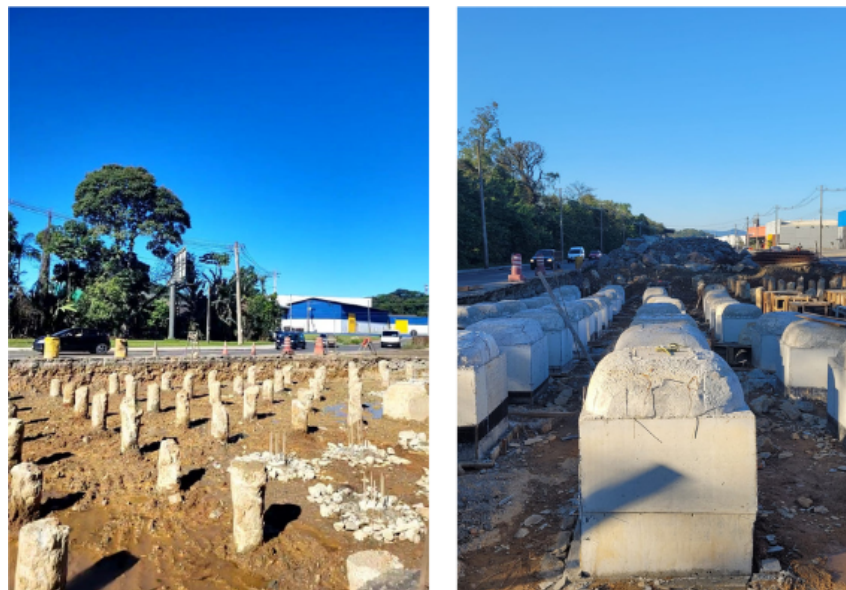
Figura 16 – Execução da obra de aterro estaqueado
