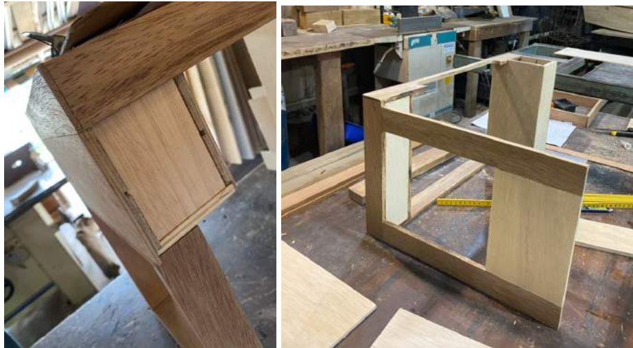
Figura 164 – pés da mesa sendo instalados
