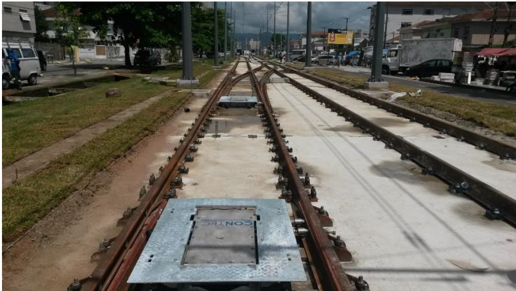
Figura 22: Sensor “Tag” para acionar o semáforo liberando o VLT.
