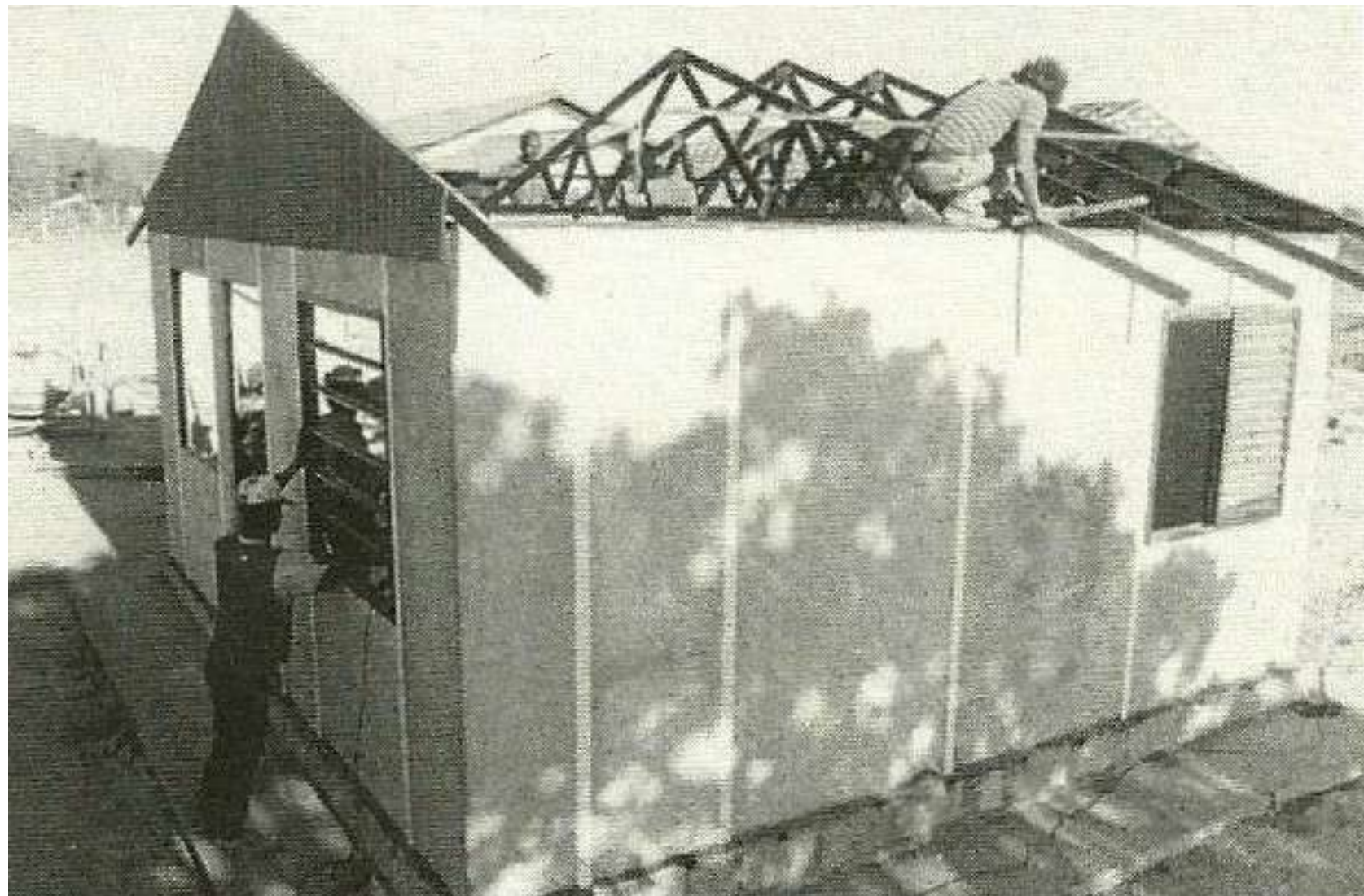
Montagem da estrutura da cobertura.
