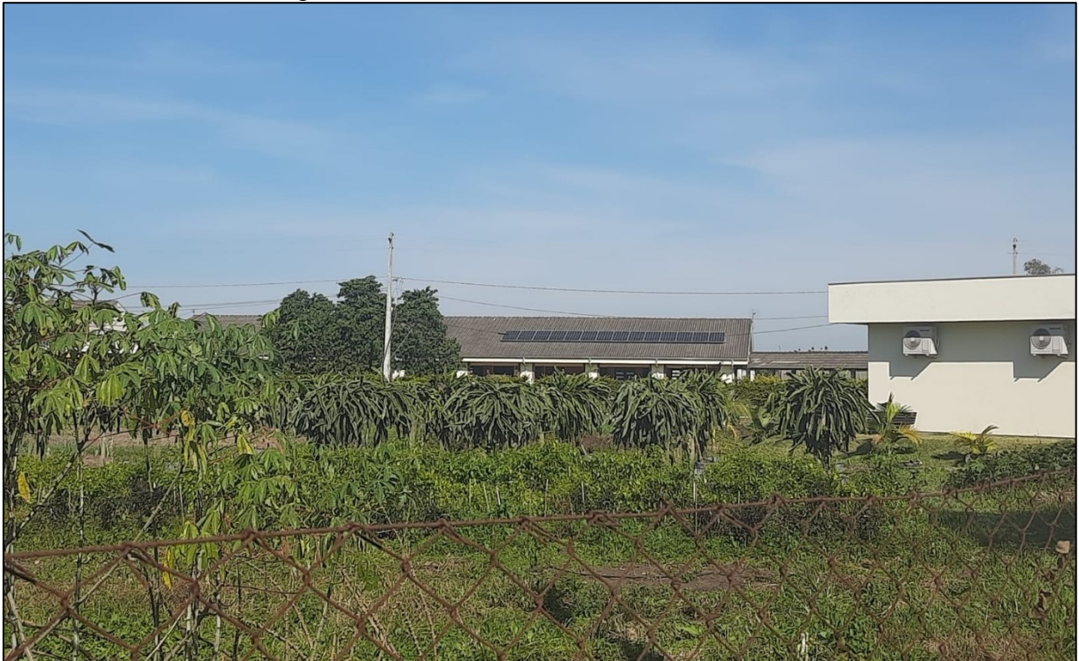
Figura 10 - Sistema fotovoltaico instalado.
