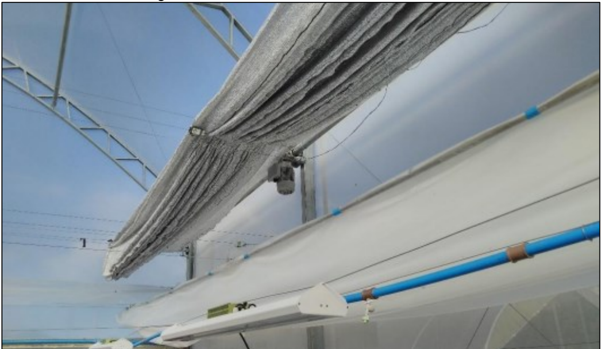
Figura 5 - Cortina de aluminet e forro móvel.
