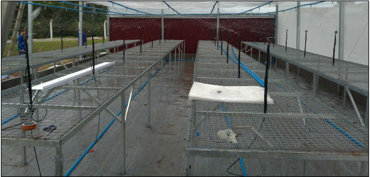
Figura 7 - Disposição das bancadas na Smart and Efficient Greenhouse.
