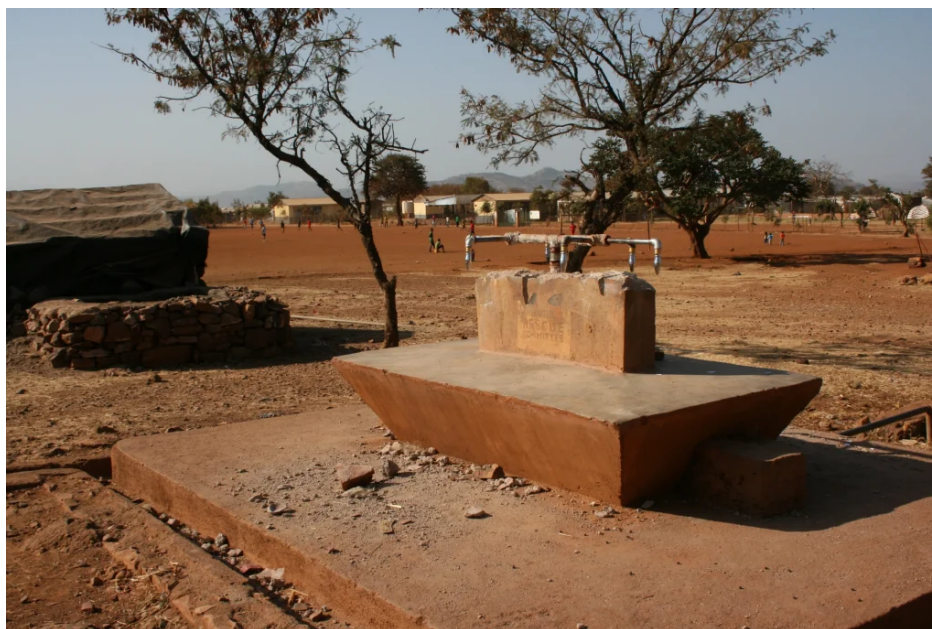
Figura 29: Ponto de acesso de água em Adi Harush. Fonte: Alianza Shire (c2023)
