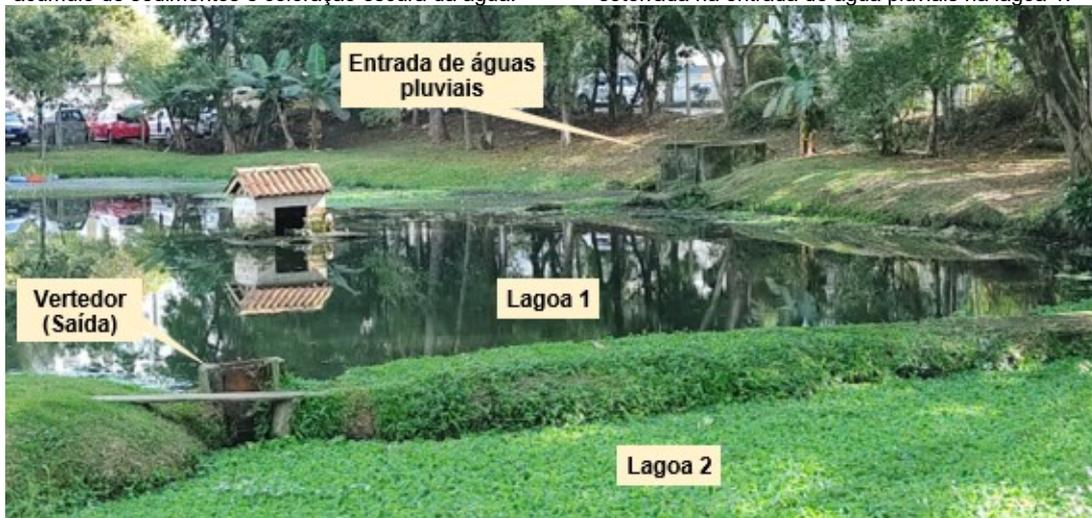
C – Localização da entrada de águas pluviais e vertedor de saída da Lagoa 1 e macrófitas de superfície na Lagoa 2. Ausência de macrófitas de superfície na Lagoa 1 em função de limpeza.
