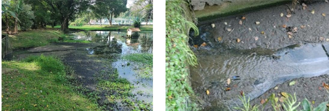
A – Detalhe da entrada de águas pluviais na Lagoa 1, acúmulo de sedimentos e coloração escura da água.
