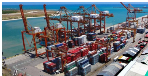
Figura 50 - Operação de contêineres nos cais 1, 2 e 3 no Porto de Suape
