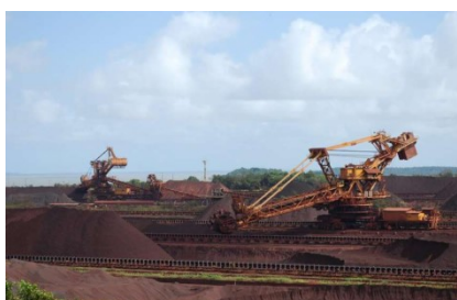
Figura 45 - Equipamento na retroárea do Terminal Marítimo Ponta da Madeira
