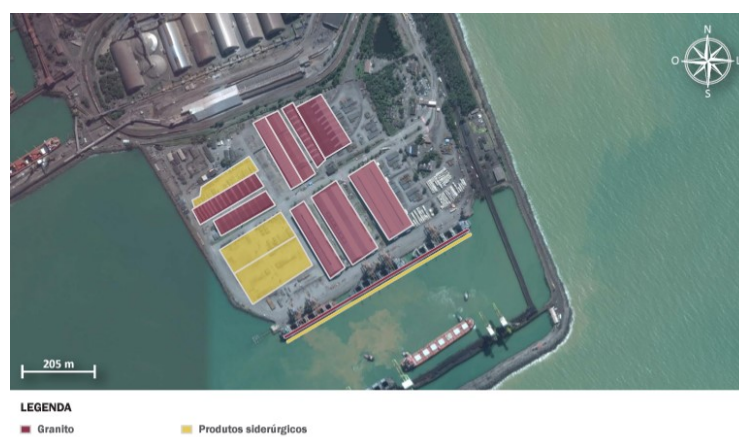
Figura 29 - Infraestrutura de acostagem Terminal Marítimo de Praia Mole
