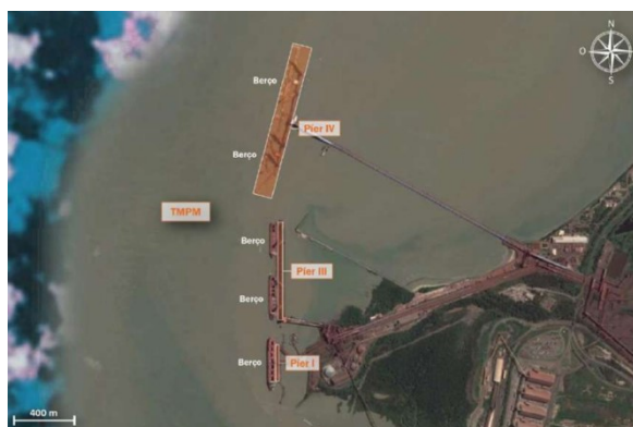
Figura 44 - Infraestrutura de acostagem do Terminal Marítimo Ponta da Madeira
