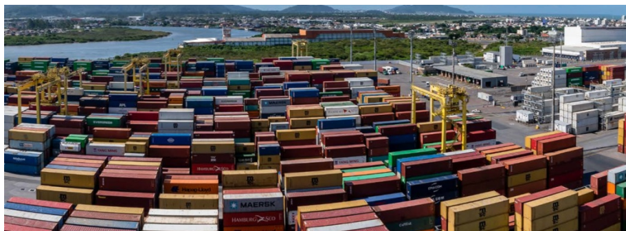
Figura 38 - Pátio de Contêineres Terminal da Portonave
