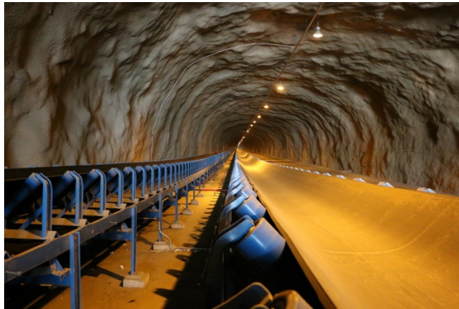
Figura 24 - Corredor de Exportação (túnel construído para escoar o granel sólido do terminal marítimo aos pátios de estocagem no Porto Sudeste
