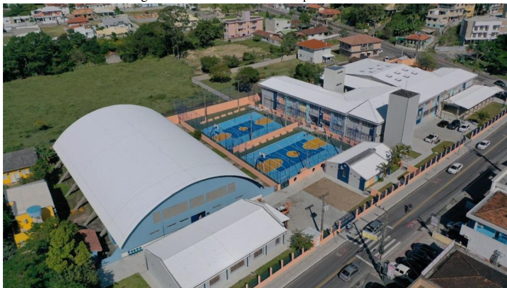
Figura 5 - Vista aérea da escola após reforma de 2019.
