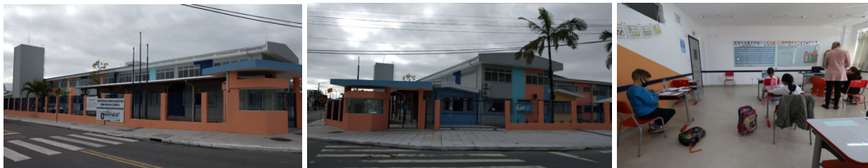
Figura 4 - Imagens da escola após a última reforma.
