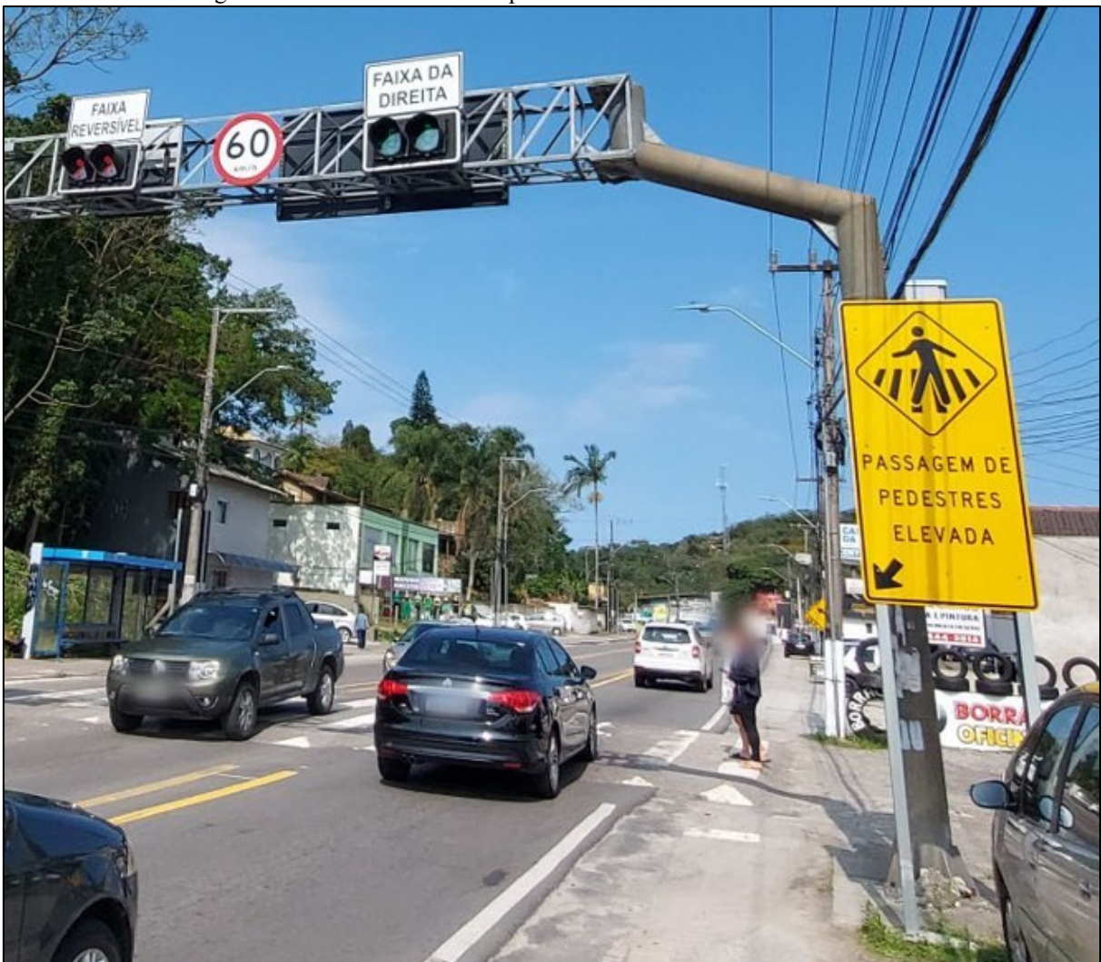
Figura 42: Travessia elevada de pedestres em faixa reversível na SC-405.
