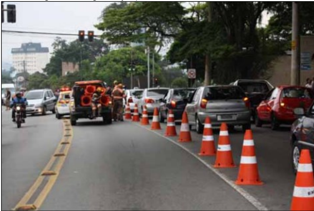
Figura 5 – Montagem de operação manual de faixa reversível em São Paulo.
