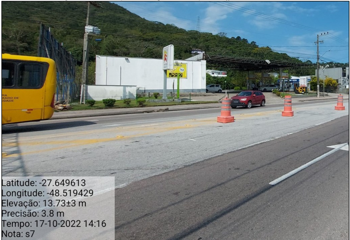
Figura 41 – Sinalização auxiliar para delimitação de buffer zone na SC-405.
