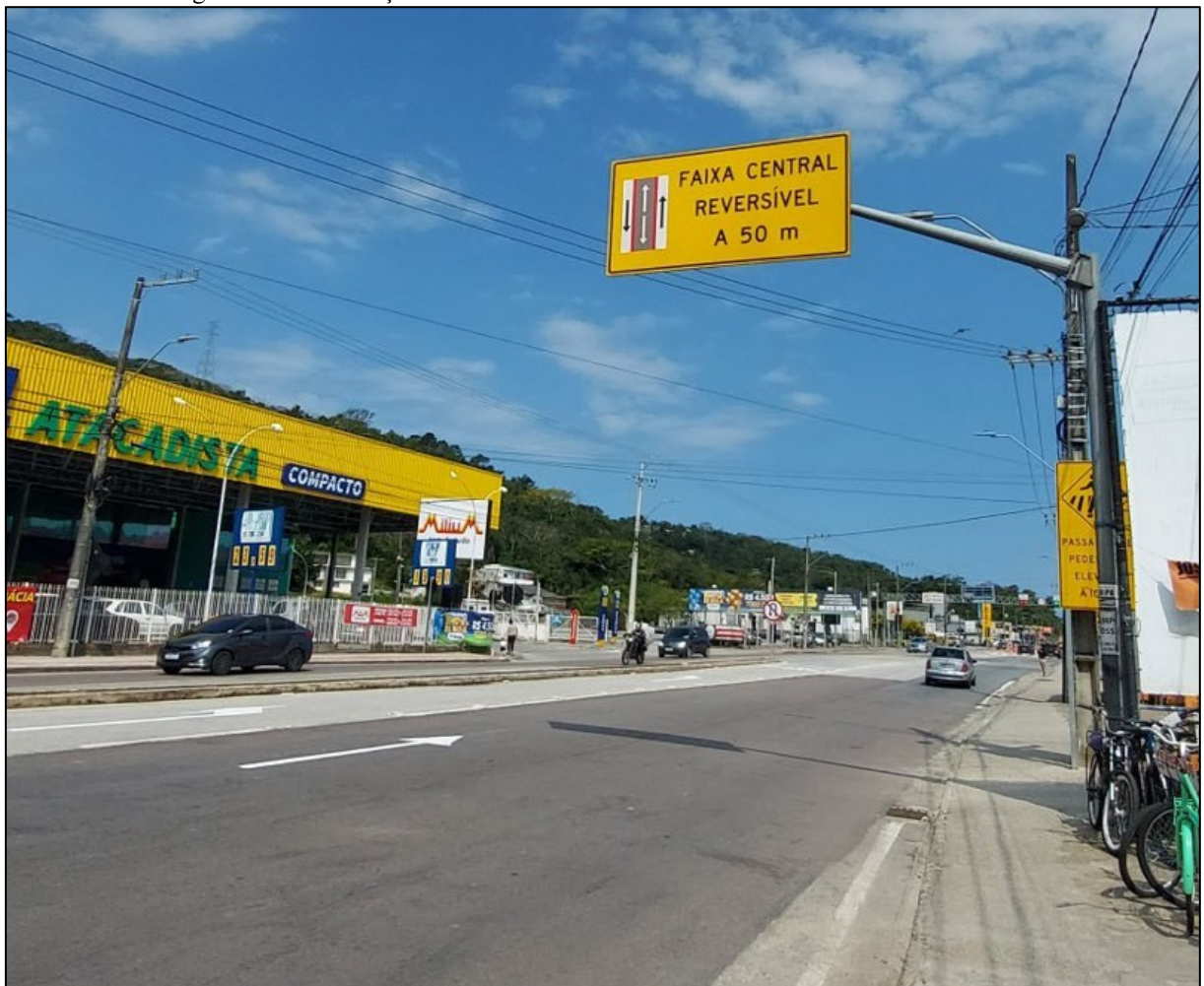
Figura 39 – Sinalização vertical indicando o início da faixa reversível na SC-405.
