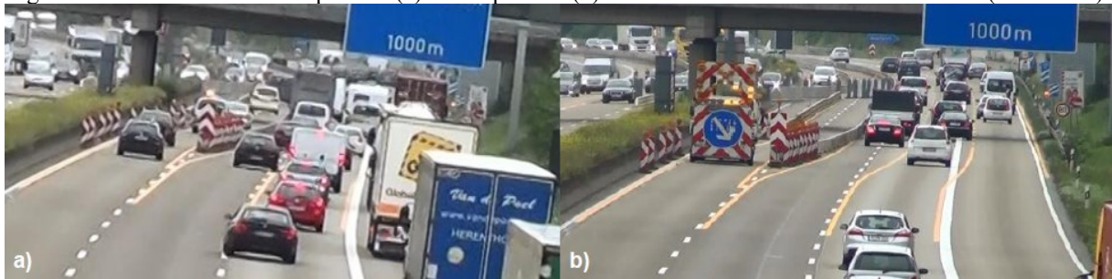
Figura 20 – Faixa reversível disponível (a) e indisponível (b) em zona de obras viárias em Frankfurt (Alemanha).
