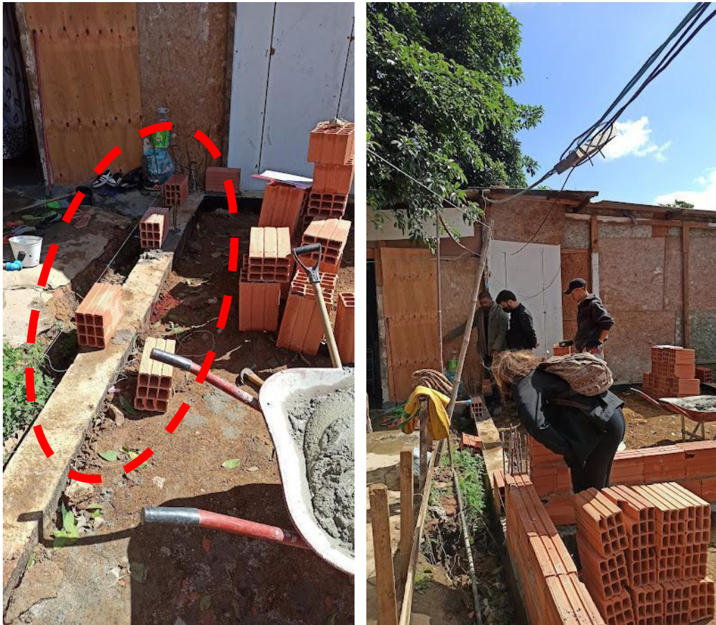
Figura 38 – Colagem fotografias indicação do baldrame e discussão em canteiro
