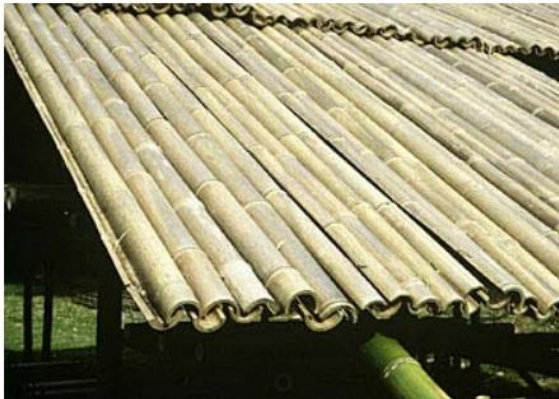
Telhas capa e canal
