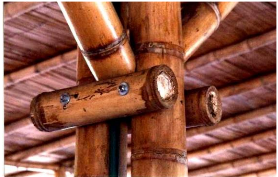
Ligações utilizando peças de bambu Fonte: Teixeira (2006)
