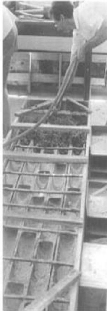
b) pouring concrete
