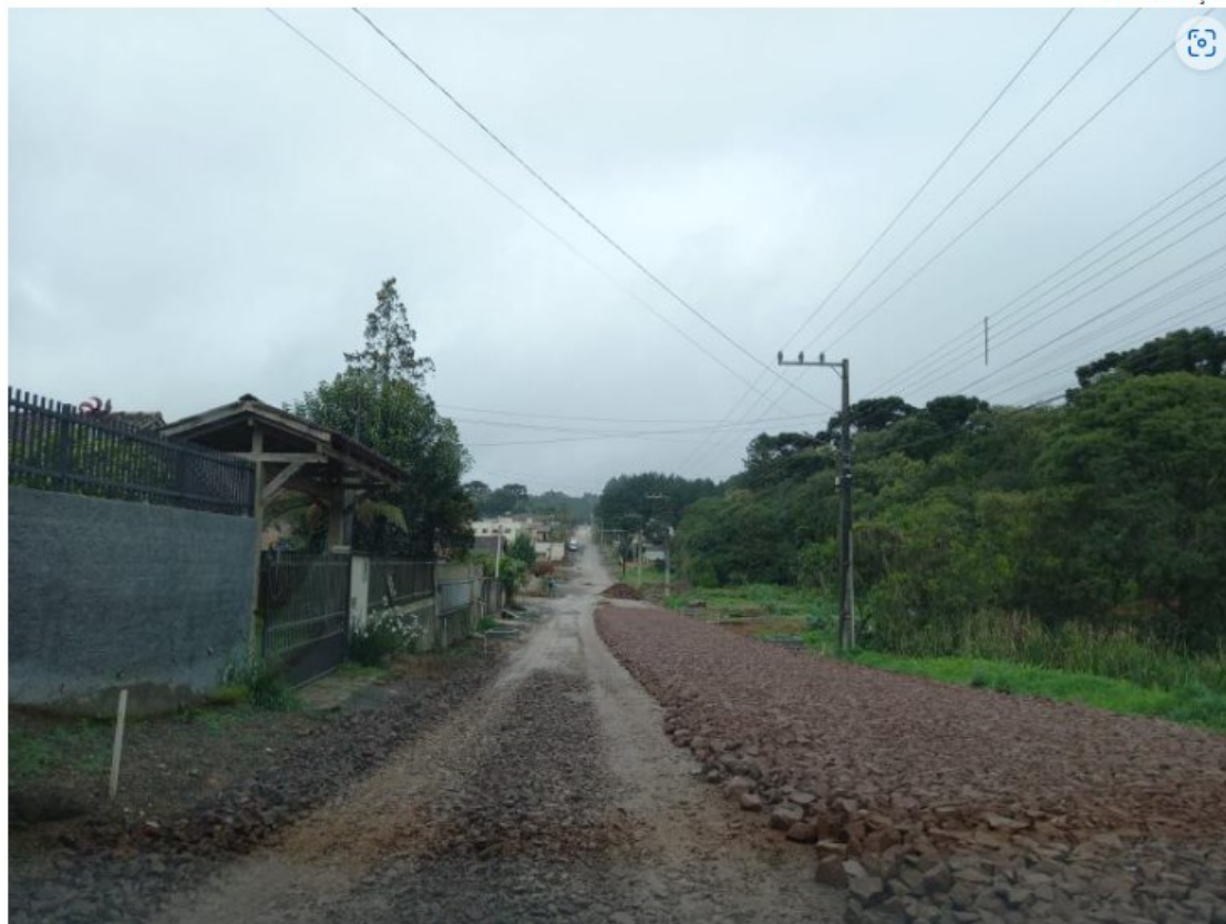
Via está sendo preparada para receber camada asfáltica
