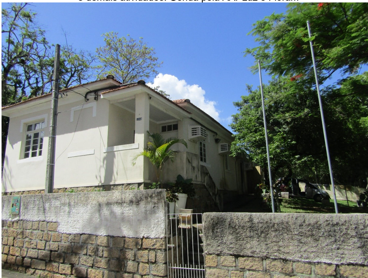
Figura 32 – Sede do Parque da Luz, edificação utilizada para exposições, reuniões e demais atividades. Gerida pela AAPLuz e Floram
