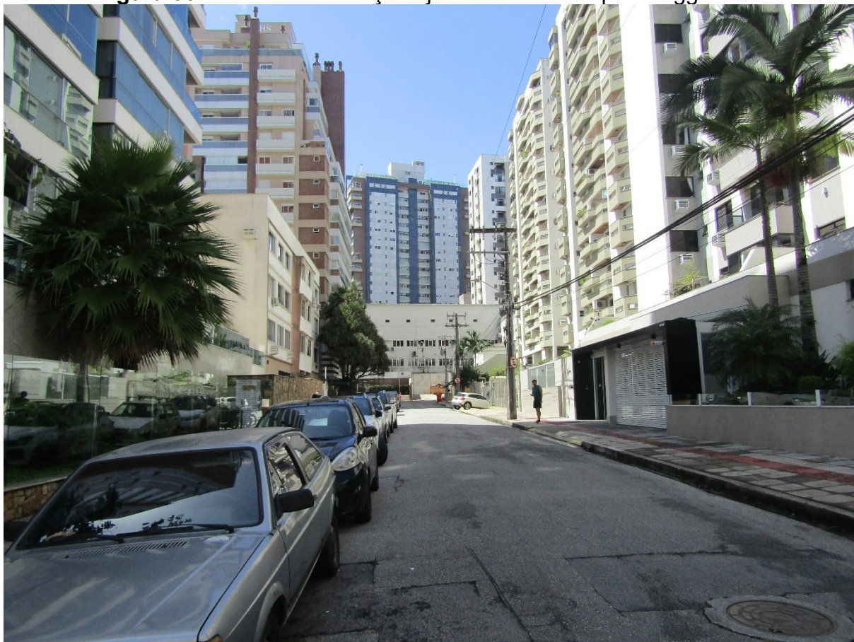
Figura 33 – Área de edificações junto a rua Henrique Bruggemann
