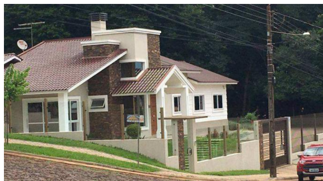
Imagem 02: fechamento misto, com muro de vidro e grades convencionais.
