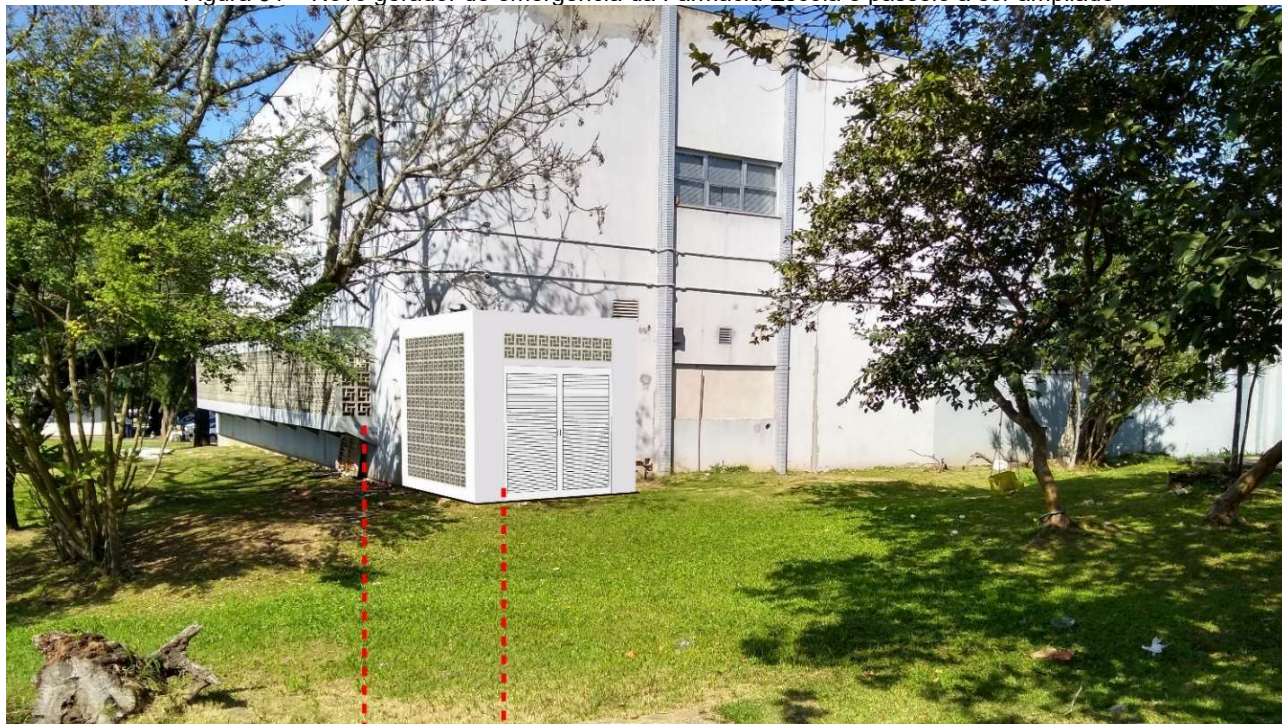
Figura 51 – Novo gerador de emergência da Farmácia Escola e passeio a ser ampliado
