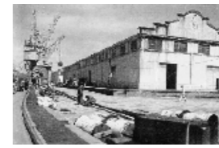
imagem 01: armazém 2 do porto de vitória visto a partir da baía Fonte: Miranda, 2001.
