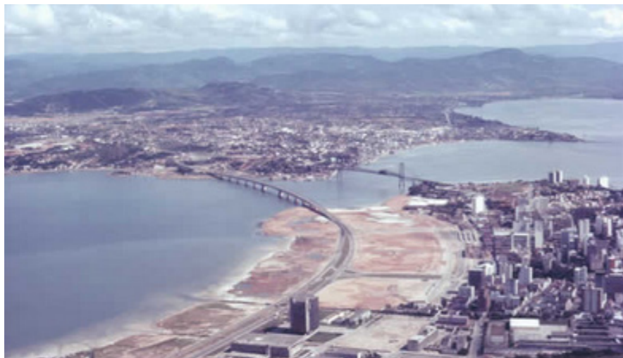
Figura 5 - Construção do Aterro Baía Sul
