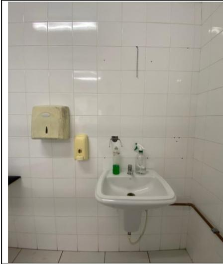
O lavatório, com coluna suspensa, está à altura de 0,9m da superfície superior do lavatório até o piso e da superfície inferior de 0,75m. Ainda, a distância entre a parte abaixo da coluna até o piso acabado é de 0,42m, dado que estes valores não batem com o designado pela norma em análise.
