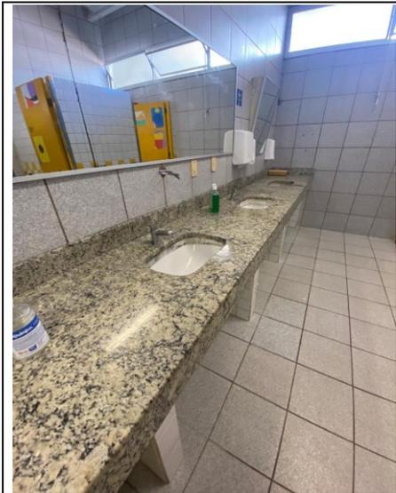
Este lavatório é do tipo sem coluna suspensa. A medida horizontal do lavatório é de 0,6m, sendo que o máximo permitido pela norma é de 0,5m. Além disso, a distância superior do lavatório até o piso é de 0,83 m e a inferior de 0,63m, as quais não estão de acordo com a norma.
