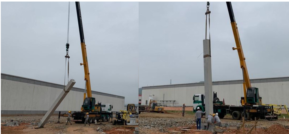
Figura 2.10 – Exemplo de levantamento de pilar.
