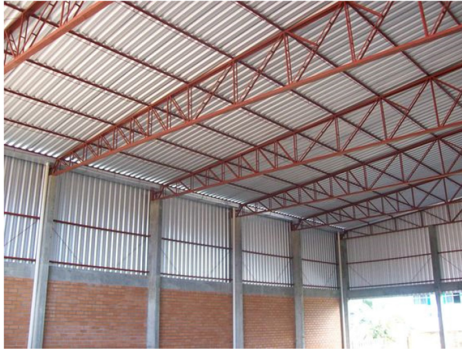
Figura 3.1 - Galpão com estrutura híbrida.
