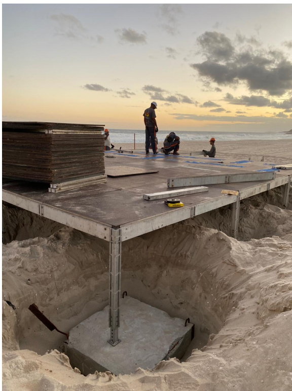
Figura 03 e 04 - À esquerda detalhe das sapatas, estrutura metálica e tablado. À direita o armazenamento dos perfis metálicos da estrutura
