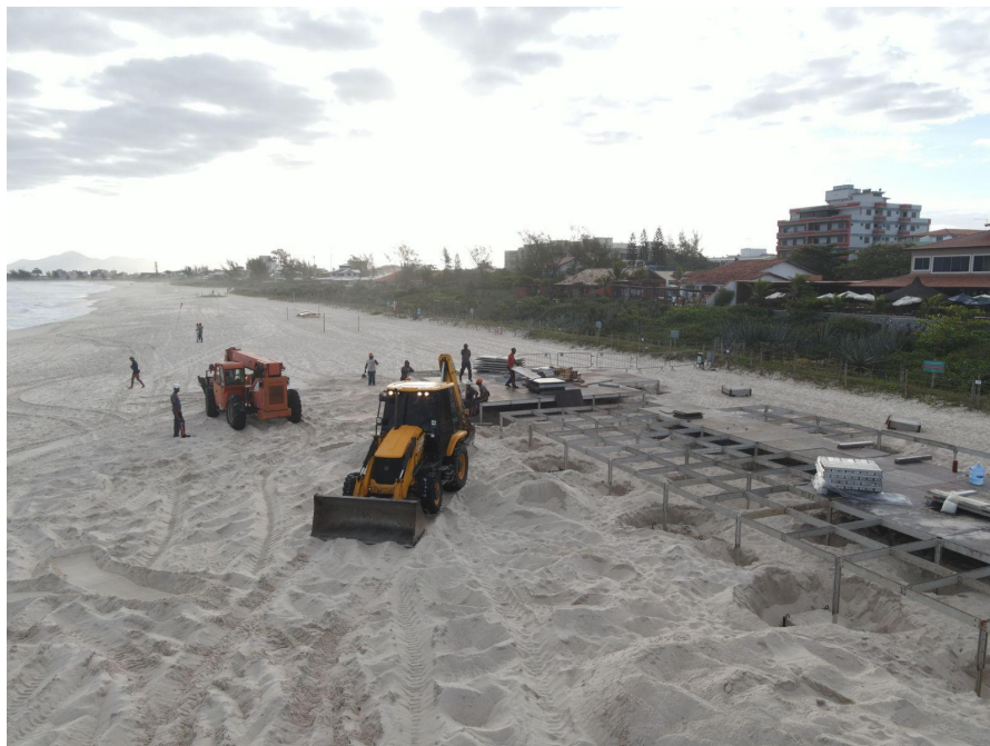
Figura 05 - Manipuladora 4x4 e retro escavadeira
