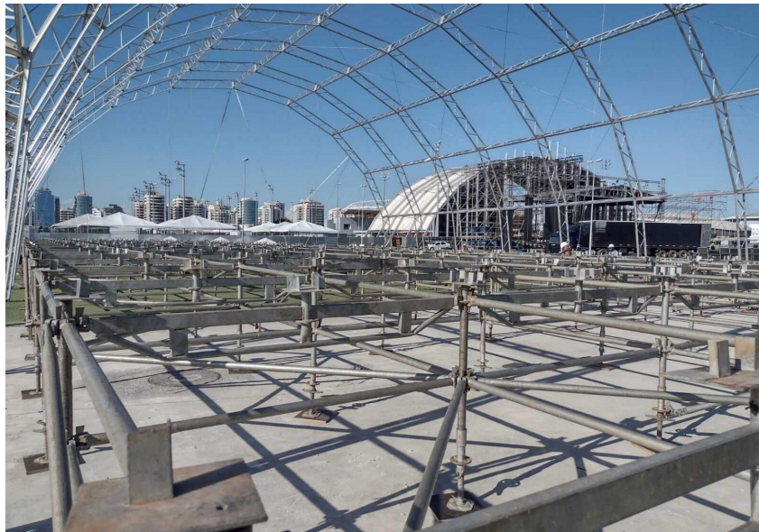
Figura 17 - Exemplo de estrutura metálica tipicamente utilizada em eventos, com estrutura tipo Q30 treliçada em alumínio na cobertura, e estrutura tubular em aço galvanizado à fogo na estrutura do piso.
