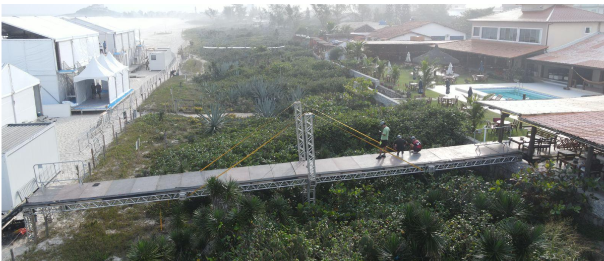
Figura 07 - Ponte construída sobre a restinga que dá acesso ao complexo do evento
