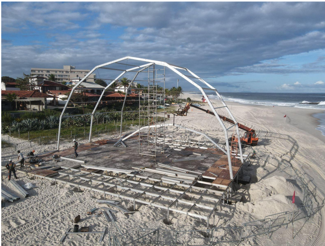
Figura 06 - Estrutura metálica do palco, instalação do tablado e situação de trabalho em altura
