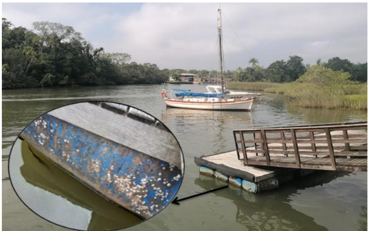
Figura 15 - Incrustação nas boias da plataforma.
