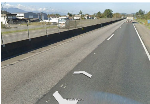
(a) Segmento dividido, km 13
