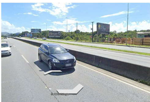
(c) Segmento dividido, km 154
