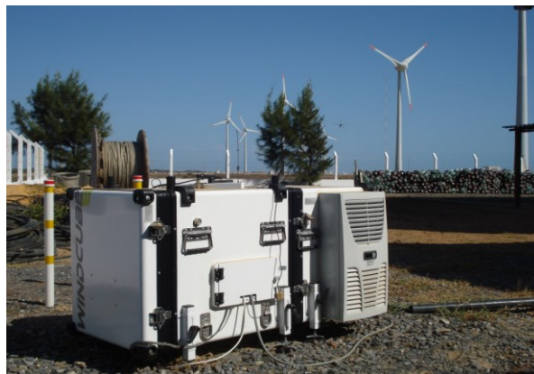
Figura 17 – Perfilador LiDAR instalado na Usina Eólica de Pedra do Sal. Fonte: (SAKAGAMI, 2017).
