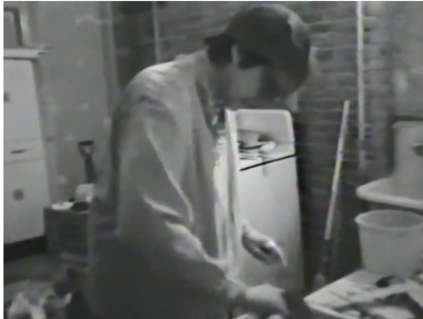
Figura 6: Carol trabalhando na reforma do apartamento.
