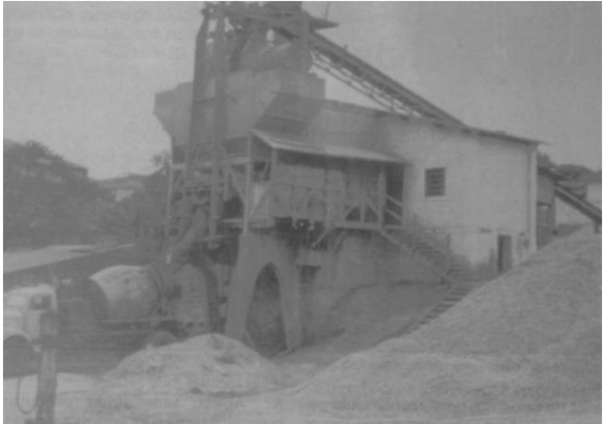
Figura 3 – Usina Central de Concreto S/A
