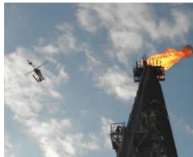
(c) Inspeção de queimadores
