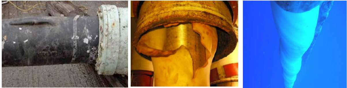
(a) Rasgo devido pressão excessiva
