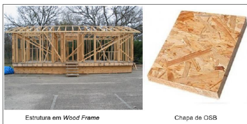
Figura 4: Estrutura em wood frame e chapa de OSB. Fonte: Tecverde, 2019.
