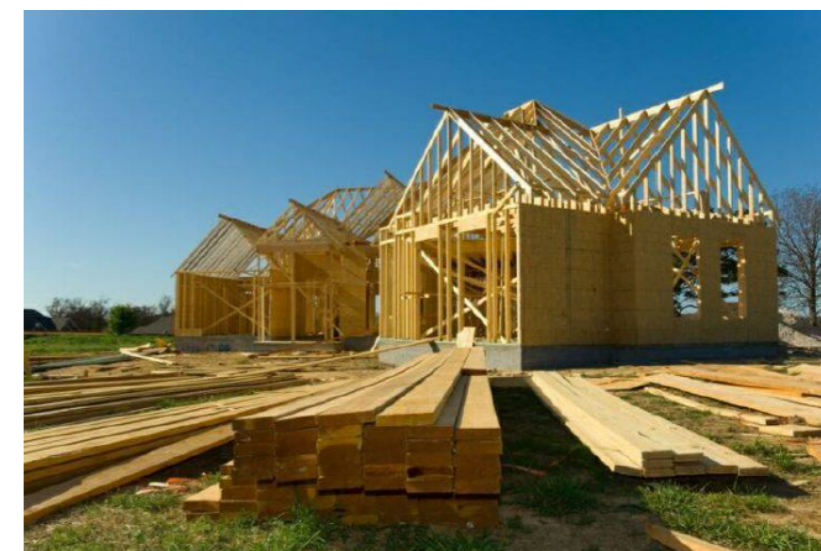
Figura 6: Residência em wood frame . Fonte: Techne, 2008.
