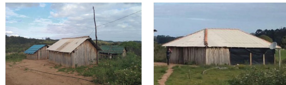
Figuras 7 e 8: Edificações em Madeira. Fonte: autoras.
