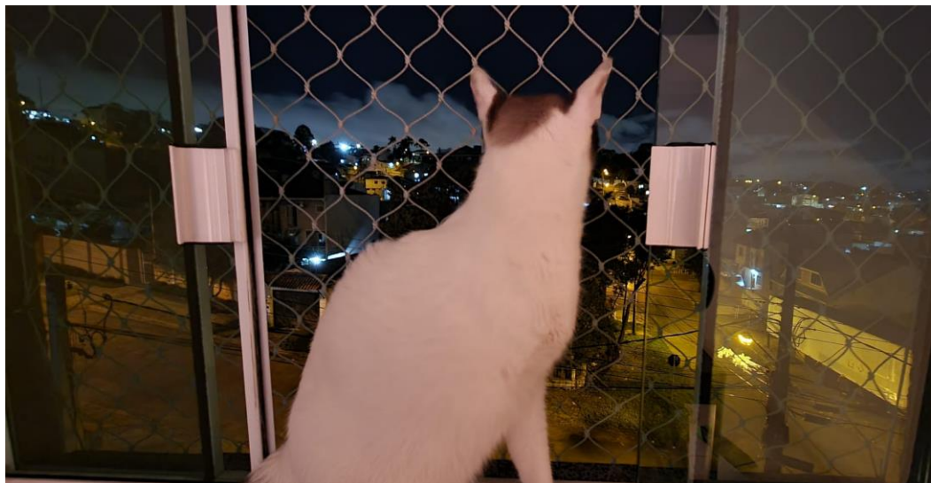
Figura 1 - Rede de proteção instalada em janela.
