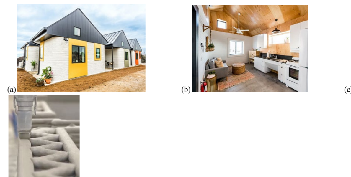
Figura 5: Vista externa (a) e interna (b) das casas e (c) impressão da parede. Fonte: ICON (2023).
