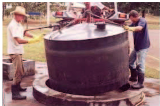
Figura 3: Instalação de aparelho biodigestor em pequena propriedade Fonte: EMBRAPA
