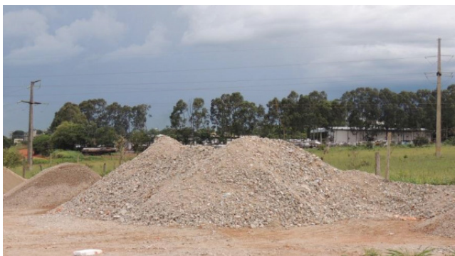
Figura 07 - Armazenamento temporário da brita graduada simples
