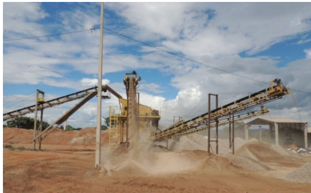
Figura 06 – Peneiramento e pilhas de armazenamento temporário dos produtos finais
