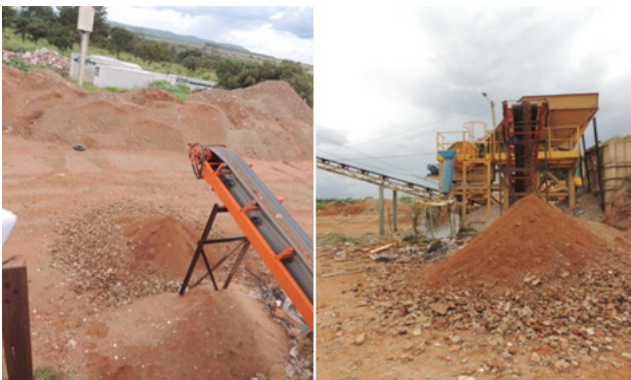
Figura 04 – Esteira e armazenamento temporário de solo e partículas finas
