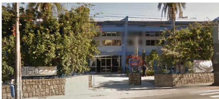
Foto 01: Foto retirada do acervo disponibilizado no google referente ao Instituto Estadual de Educação. A foto ilustra a entrada da escola localizada na Avenida Mauro Ramos.
