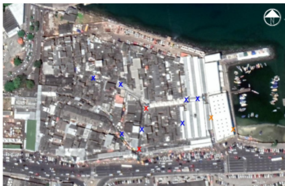
Figura 10: Problemas de Infraestrutura
