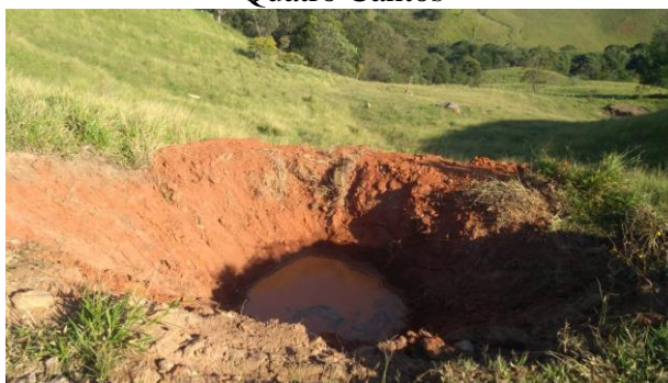
Figura 5: Barraginha instalada em terreno declivoso de uma propriedade rural no Bairro Quatro Cantos
