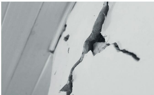
Ao longo dos diversos setores do IPQ, o cenário, composto por grandes rachaduras nas paredes, se repete
