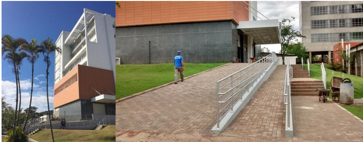
Figura 34– Rampas de acessibilidade no CCE
