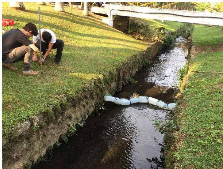
Figura 47 – Colocação de barreira de resíduos no córrego
