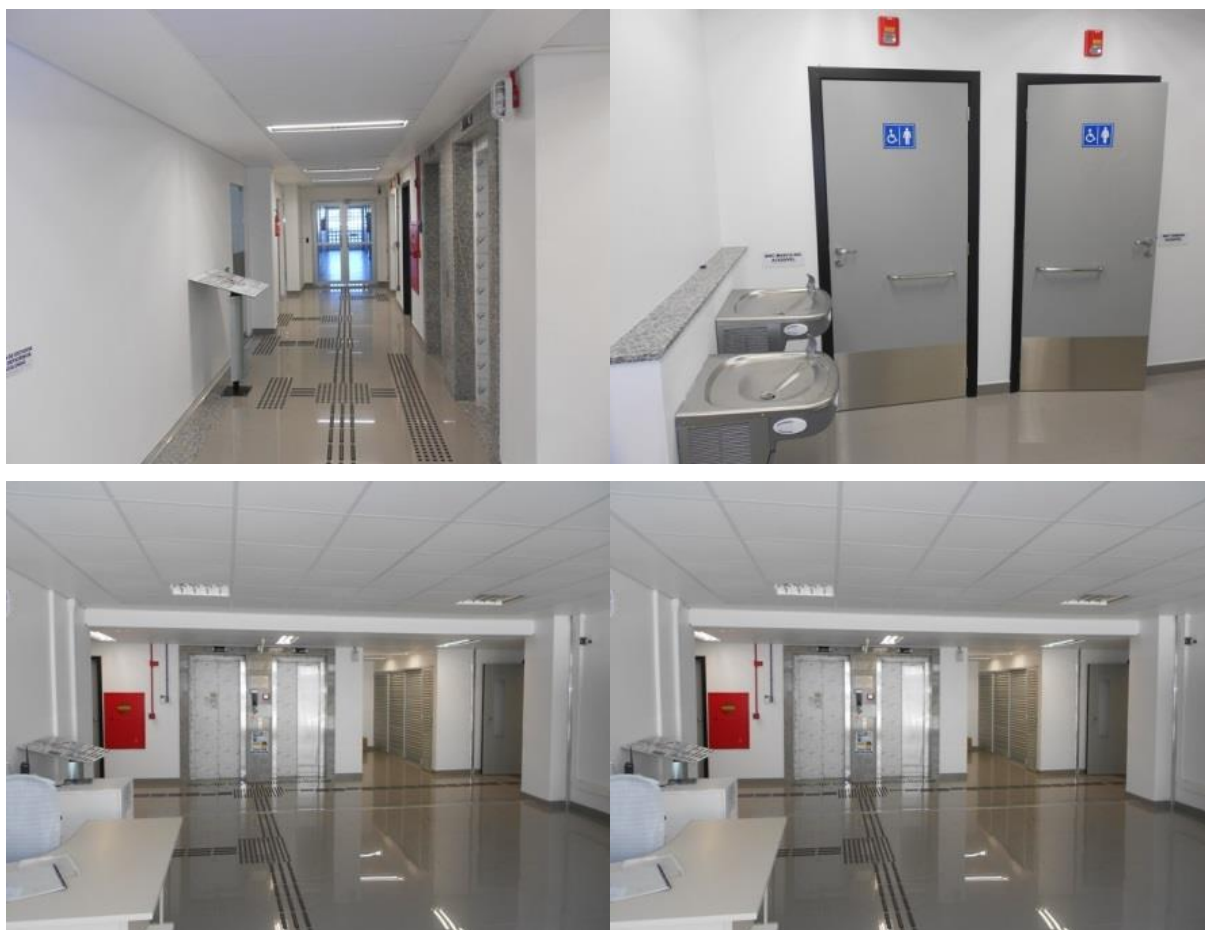
Figura 33– Mosaico – Sinalização tátil – Bloco E/F e Anexo do CFH
