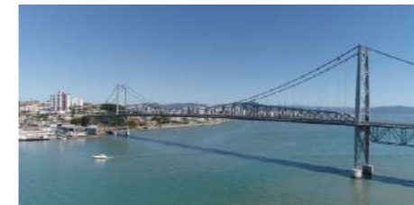
Ponte Hercílio Luz
