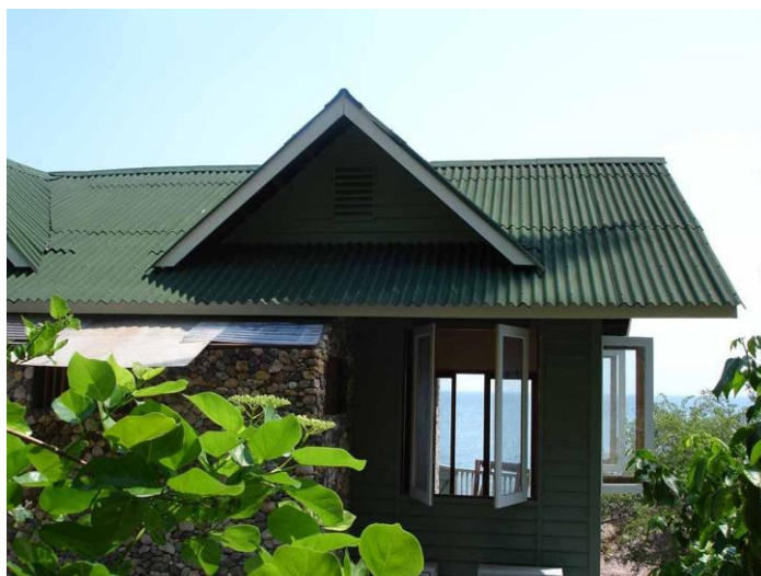
Figura 5 – Telha ecológica vegetal. Fonte: Leves (2021).
