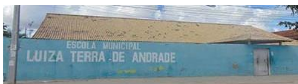
Figura 1: Fachada principal da E. M. Luiza Terra de Andrade. Fonte: SILVA e BRASIL, 2019.
